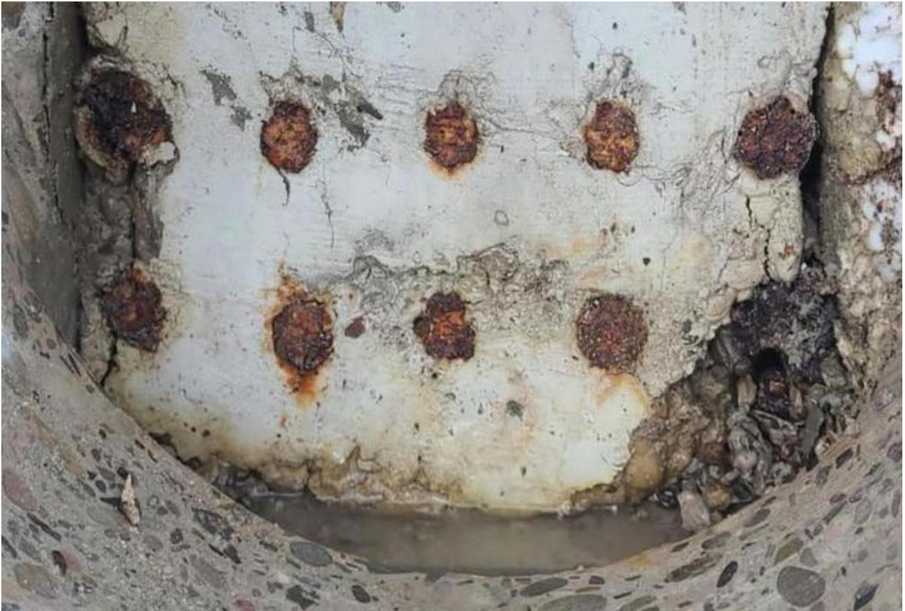
Blick auf die Stirnseite eines der Beton-Binder der Erich-Kästner-Schule in Oberursel: Die äußeren Stahl-Litzen sind kaum von Beton umgeben, was sich negativ auf die Statik auswirkt. FOTO: Kreis
